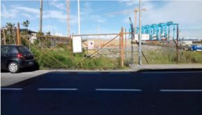
FOTO 4 INSUFFICIENTE DECORO URBANO CANTIERE LATO MARE
