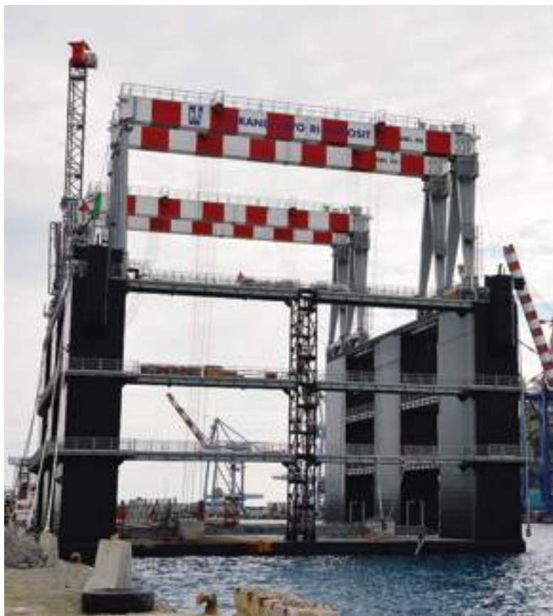
L'impianto per la realizzazione dei cassoni necessari alla piattaforma
